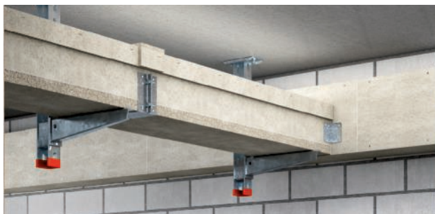
Combinaison d'un conduit sur système de supportage avec un conduit mural
