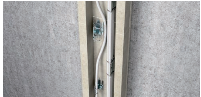
Installations de câbles verticales grâce aux porte-câbles
