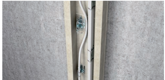
Posa verticale dei cavi mediante supporto cavi
