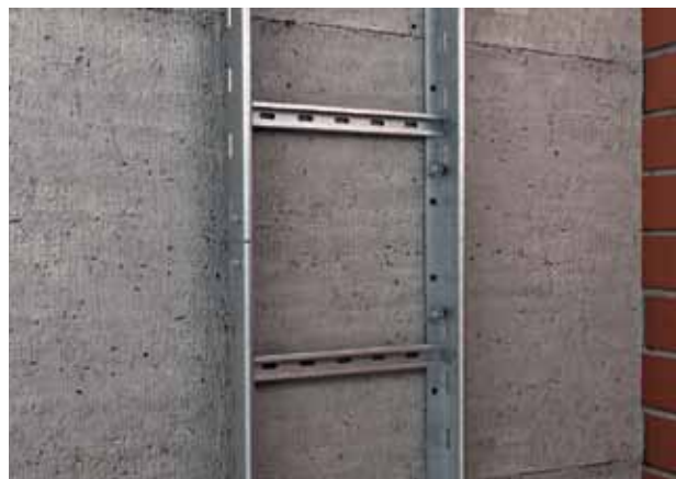
Montage direct des échelles verticales sur mur massif.
