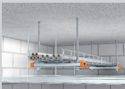
Montage au plafond sur un niveau avec un rail de montage.
