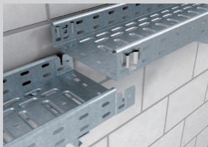
Éclissage effectué par l'emboîtement des chemins de câbles entre eux.
