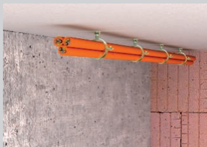
Pose de faisceau de câbles sous plafond.
