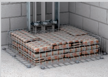
Dispositif anti-glissement au-dessus du plancher.
