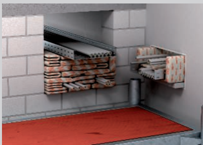
Obturation de l'ouverture avec des coussins - sans mastic ni couche de peinture.
