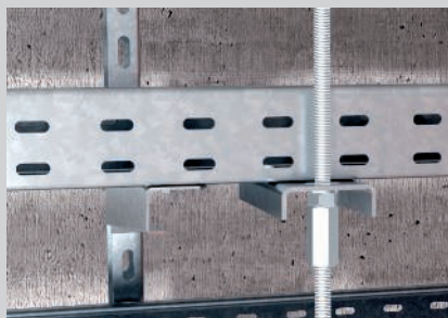
Fixation de tiges filetées sur le chemin de câbles en cas de disposition multi-niveaux.
