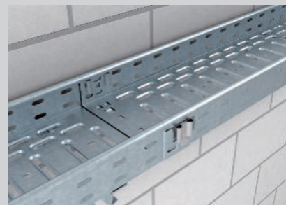
Éclissage couvre-joint sans vis terminé.
