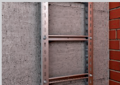
Montage direct des échelles verticales SLM sur mur massif.
