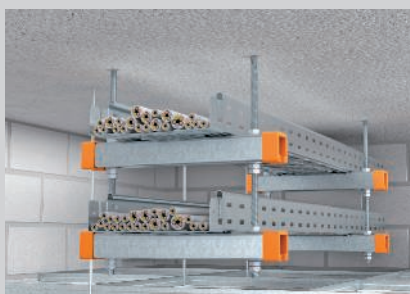
Montage au plafond sur deux niveaux avec rails de montage.
