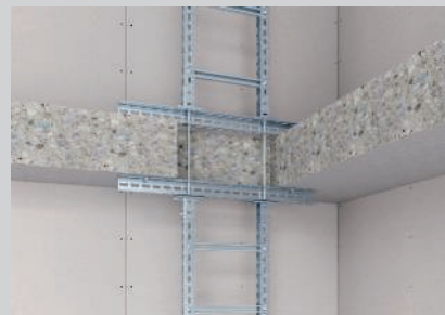
Montage de l'échelle verticale en continu sous une ouverture de plafond avec des profilés transversaux et des semelles.
