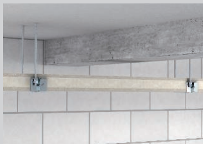
Montage suspendu par les éclisses.
