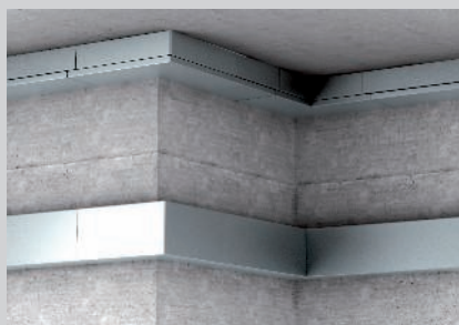
Montage horizontal au mur et au plafond.
