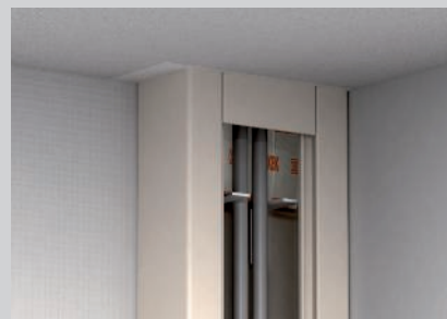
Équerres empêchant le glissement des installations effectuées à la verticale.
