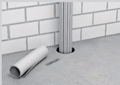
Préparation du calfeutrement de câbles.
