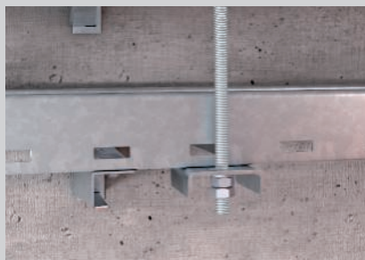
Fixation de la tige filetée verticale sur la pièce de raccordement.
