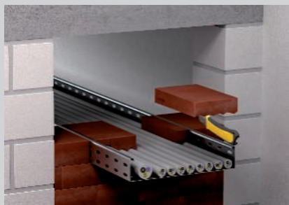
Installation des blocs découpés.
