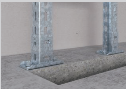
Semelles montées sur le sol pour stabiliser les montants de l'échelle.
