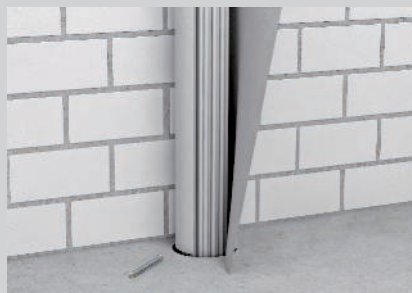
Installation du bandage coupe-feu.
