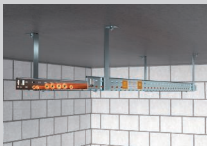
Montage au plafond sur un niveau à l'aide d'un étrier de suspension.
