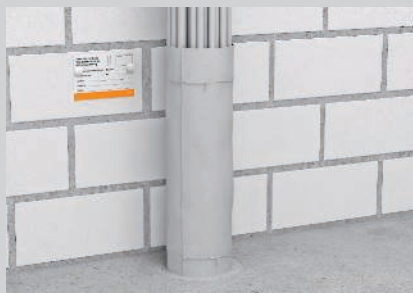
Boucher les trous du calfeutrement avec du mortier et monter la plaque d'identification.
