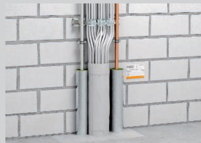
Installation du bandage coupe-feu avec écart zéro par rapport au calfeutrement de tube Rockwool Conlit.
