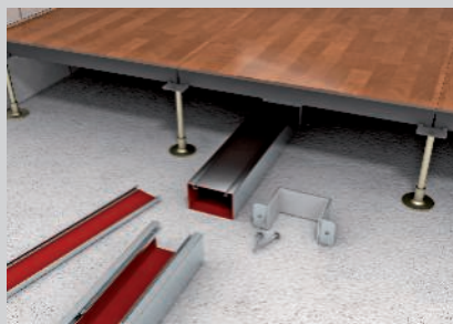
Montaggio sotto i pavimenti sovrapposti.
