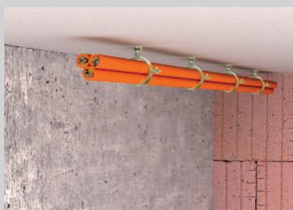
Posa dei cavi in fasci sotto il soffitto.
