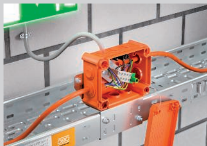
FireBox montata con piastra di montaggio a la passerella.
