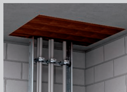
Installazione dei mattoncini senza l'utilizzo della griglia nei passaggi verticali soffitto-pavimento.
