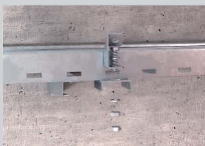
Montaggio del componente di collegamento con vite a testa esagonale e dadi esagonali.
