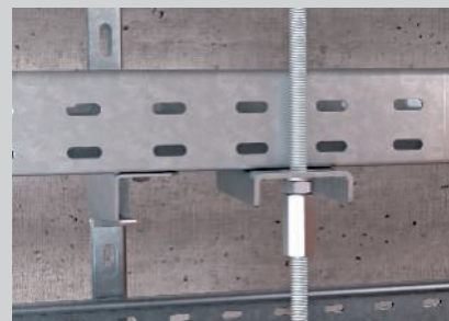
Fissaggio dell'asta filettata sulla passerella con disposizione a più strati.
