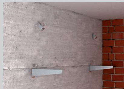
Montaggio della mensola e dei componenti di collegamento obliqui alla parete.
