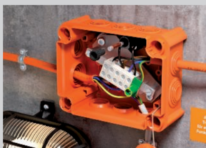
Ingresso cavi con passacavi morbidi.
