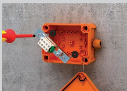
Montaggio con tiranti a vite antincendio attraverso la staffa e il fondo del FireBox.
