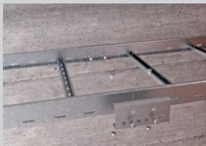
Montaggio dei giunti longitudinali con viti a testa tonda.
