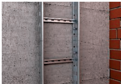
Montage direct des échelles verticales LG sur mur massif.
