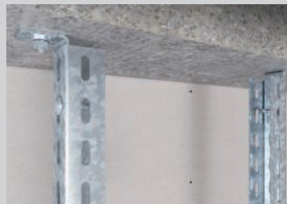
Fixation au plafond des montants de l'échelle avec des équerres de montage qui se vissent.
