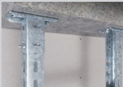
Fixation au plafond des montants de l'échelle avec des semelles qui se vissent.
