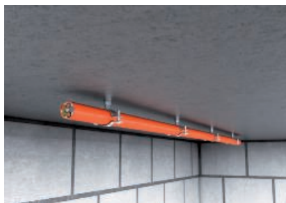
Montage sous plafond.
