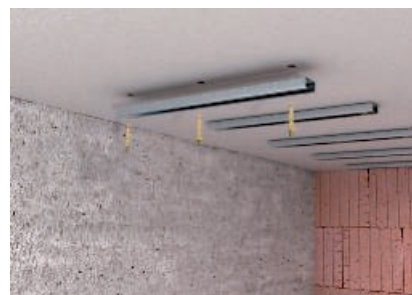
Fixer les rails profilés à l'aide de chevilles adaptées au support. Écartement maximal des chevilles à l'intérieur du rail 25 cm
