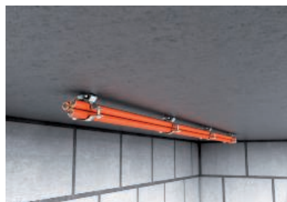
Pose de faisceau de câbles sous plafond.
