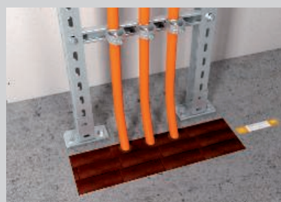
Fermeture de l'ouverture du plafond avec un système de calfeutrement agréé.
