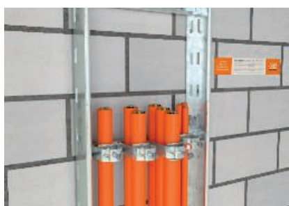
Fissaggio dei cavi singoli o multipli con staffe reggicavo 2056 M.
