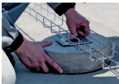
Adattatore di montaggio TrayFix e piastra di fissaggio: posizionare, premere, fatto
