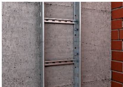
Montaggio diretto della passerella a scaletta LG su parete massiccia.
