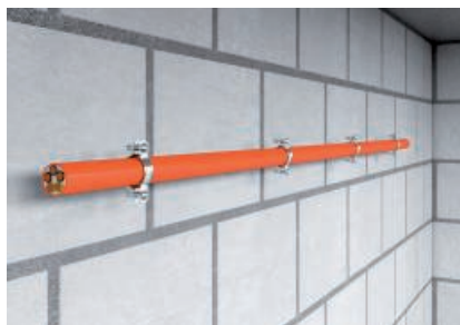
Montaggio orizzontale dei cavi sulla parete.
