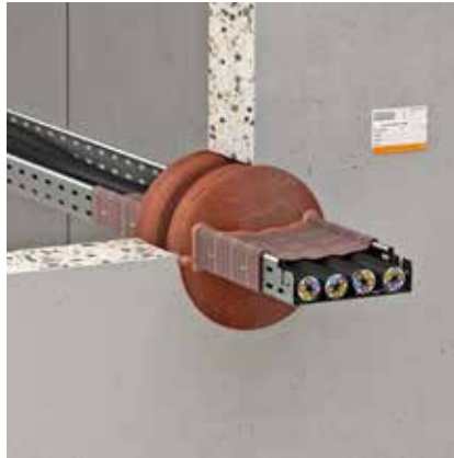
Abb. 8: Einsatz des Kabelwickels FBA-WI
