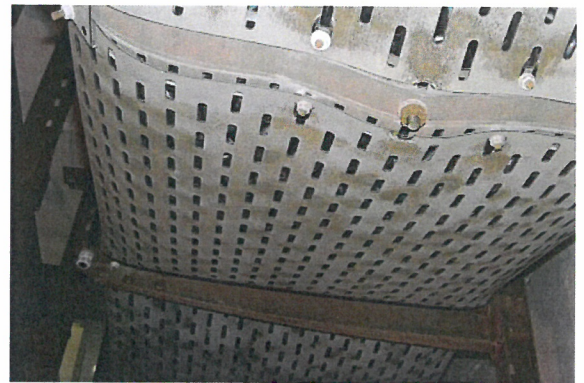
Bild 2: Ausleger Typ AW30Fxx (L = 610 mm)
