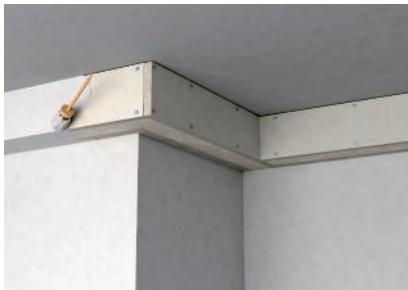
Abschließende Oberflächenbehandlung durch Streichen oder Tapezieren.
